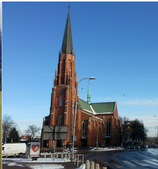
Kostel v Mysłowicích
